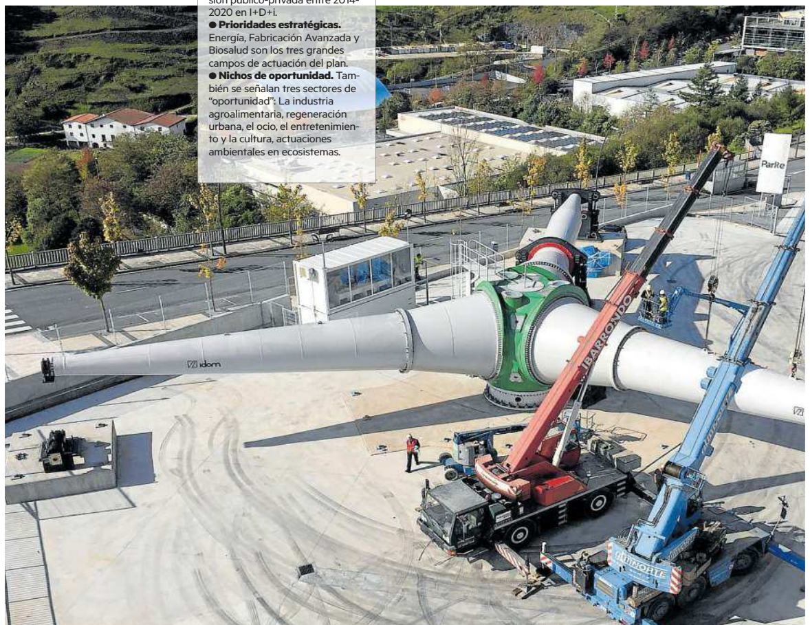
Las obras del Tripala, el banco de pruebas de Windbox que permite testar aerogeneradores completos, concluirán en breve. Foto: DNA
