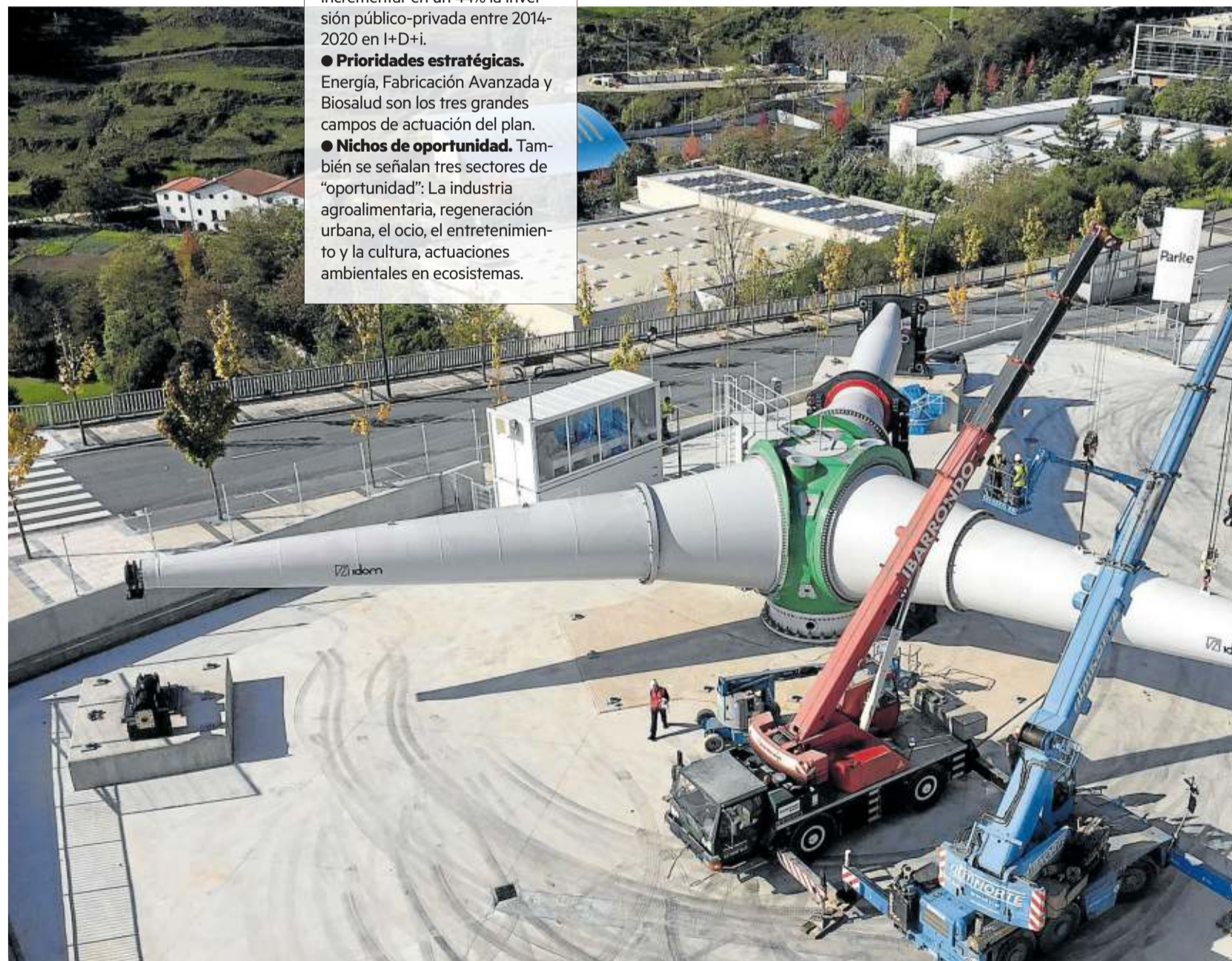
Las obras del Tripala, el banco de pruebas de Windbox que permite testar aerogeneradores completos, concluirán en breve. Foto: N.G.
