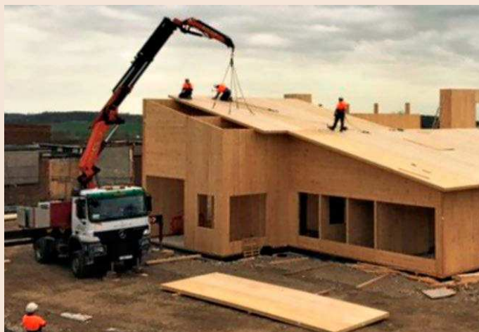
Construcción de las escuelas Abbey Court.
